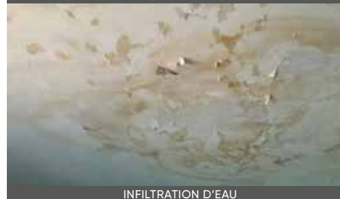
INFILTRATION D'EAU
