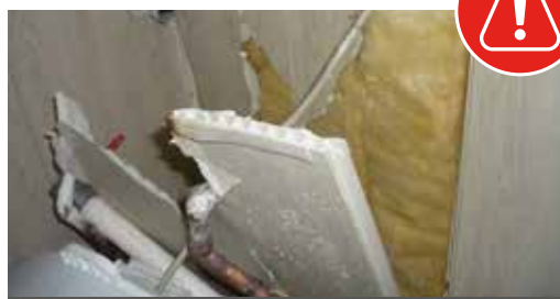
ARRACHEMENT DU MUR
